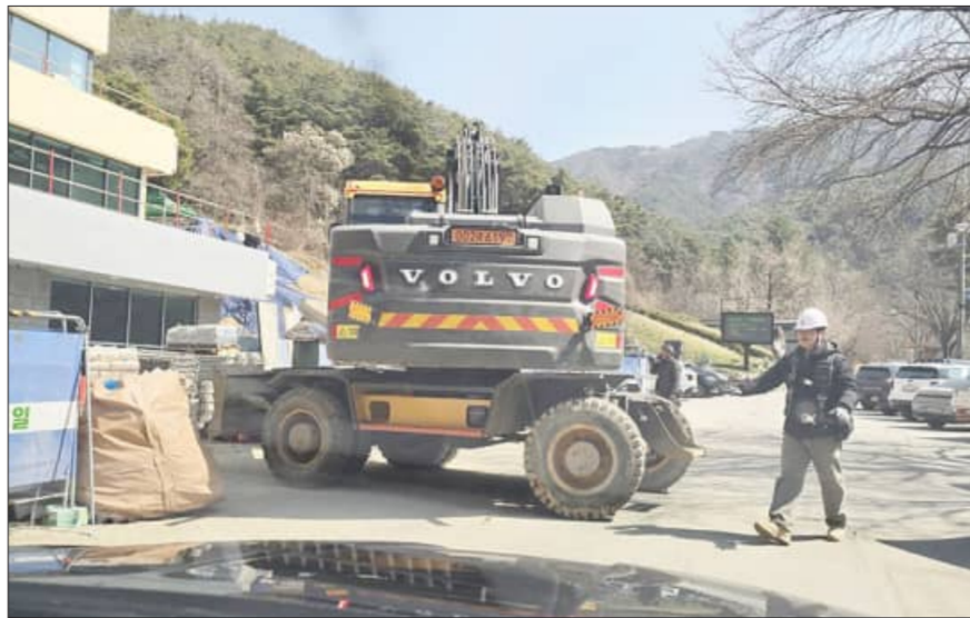
지리산 국립공원 전북지사 신축 공사 현장
