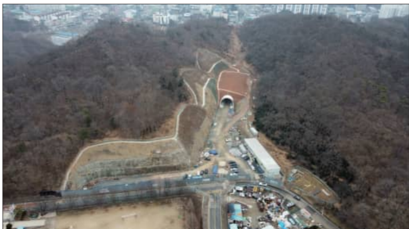
4도지~리츠프라자호텔 도로개설 및 확장공사 산북중방면
