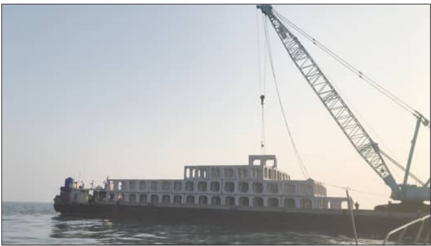
사각형 콘크리트어초 설치 사진
