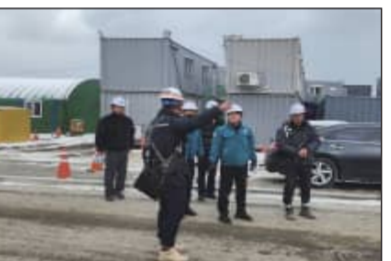
새만금개발청(청장 김경안, 이하 새만금청)은 2월 4일 폭설과 한파로 인한 기상특보에 따라 새만금지역 내 건설 현장 등을 철저히 점검하고 안전 대비에 돌입했다.
