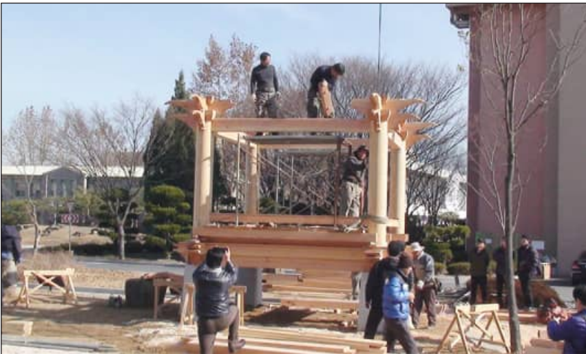
한옥 시공 실습 모습
